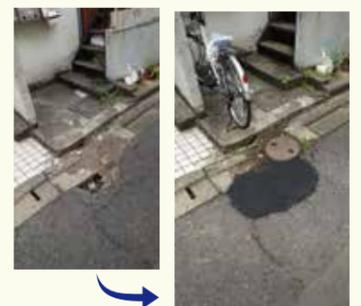
赤坂7丁目の路地の側溝が重量車両の通行で陥没し、排水溝に開いてしまった空洞を緊急補修いたしました。
