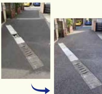
西麻布2丁目路地の側溝が破損、歩行者、自転車、車の通行に危険なため、緊急に修復し原状回復しました。
