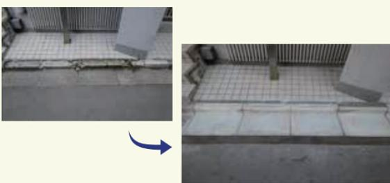
六本木7丁目の路地でL字型側溝が折損、陥没したため修復しました。幅員の狭い一方通行の道で、車を避ける歩行者などの安全確保のため、早目に修復しました。
