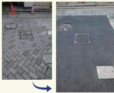
赤坂3丁目みすじ通りのマンホールを修復しました。ブロック舗装の車道が陥没し危険、とのお声をうけアスファルトで補修。このあと周囲と同じブロック様デザインに仕上げています。
